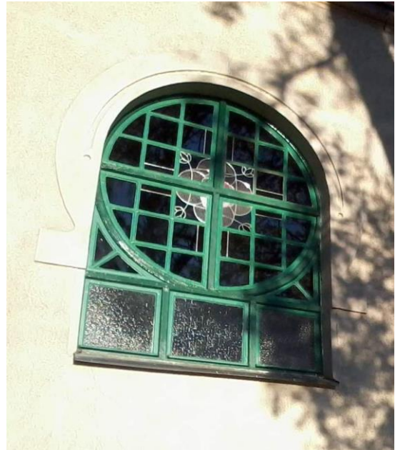
Abb. 4) Nach der Renovierung
