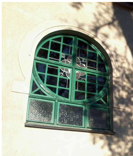
obr.4 - okna po obnově nátěrů
